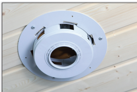
Bild 6: Eingelassene Montage mit herausgedrehten Innenteil
