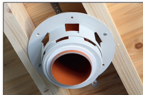
Bild 12: Montage mit starren Abluftrohr (z.B. Entlüfter)
