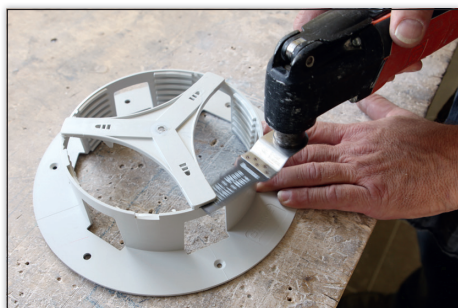
Bild 2: Stegabtrennung bei Aufbaumontage mit 3 Randschrauben
