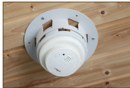
Bild 9: Montage für Rauchmelder
